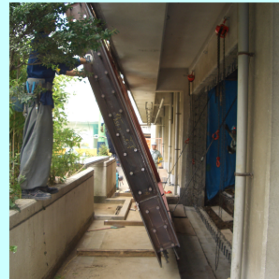
鉄骨ブレース耐震補強
