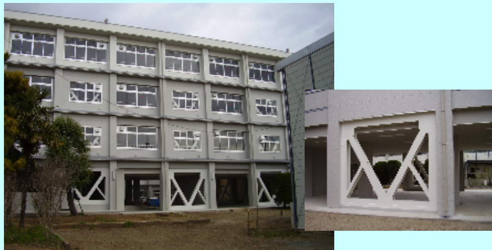
鋼板柱巻き補強
