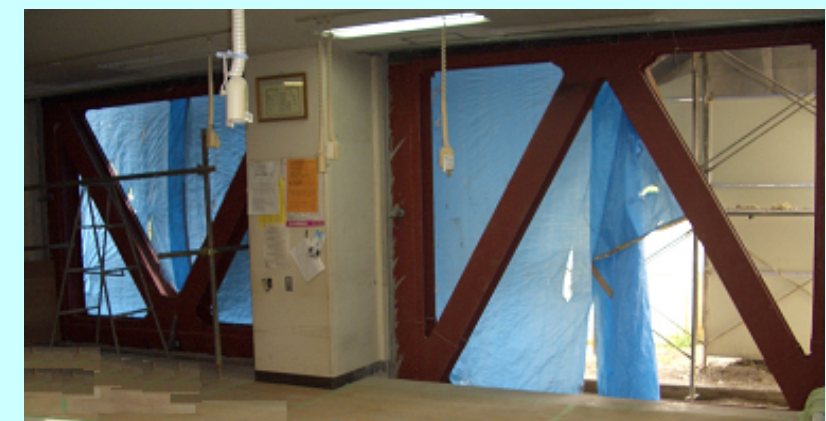
鉄骨ブレース耐震補強
