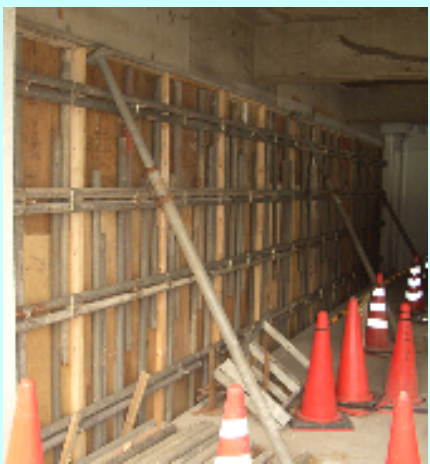
RC 耐震壁補強
