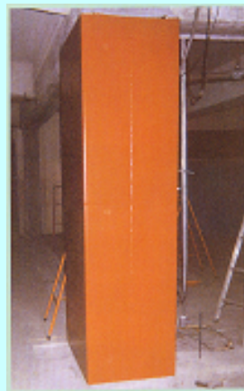
鋼板柱巻き補強
