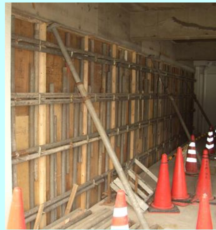
RC 耐震壁補強
