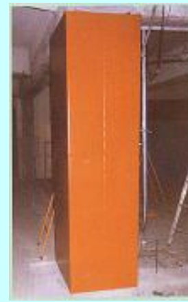
鋼板柱巻き補強
